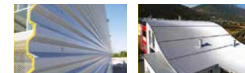
INSTALLAZIONE VERTICALE COPERTURA CON TEK 28
